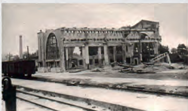
Разрушенный вокзал в Бежице.
