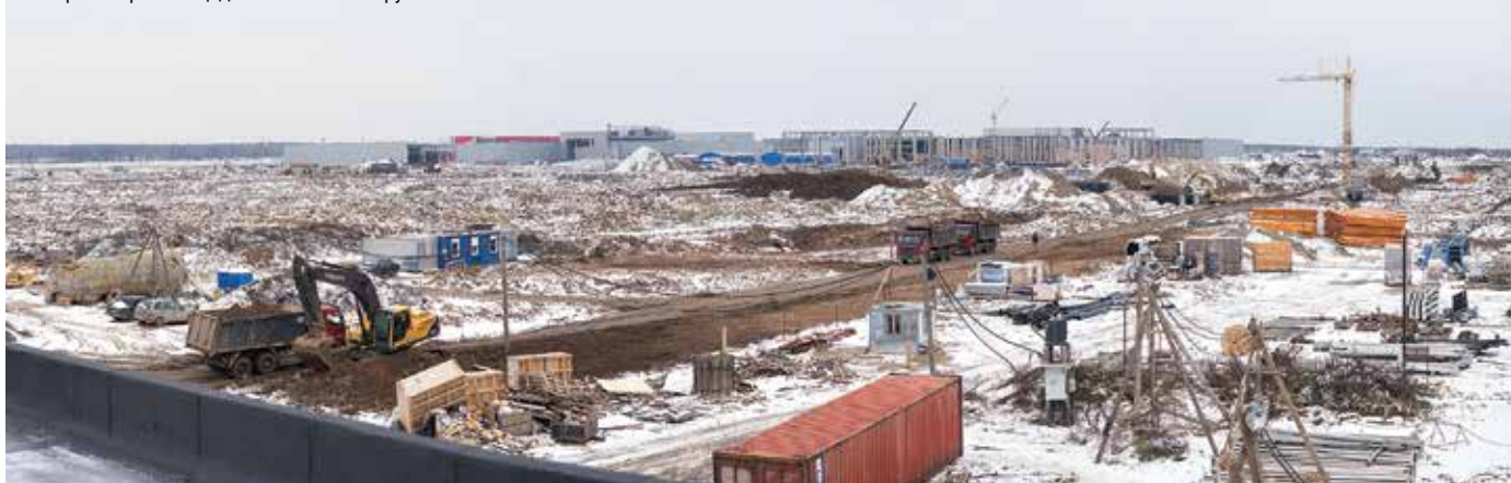
Панорама стройплощадки с очистных сооружений
